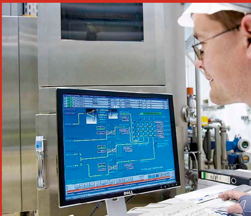
Sistema de control de procesos Botec
