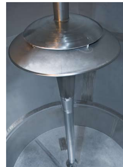
Vista del interior
